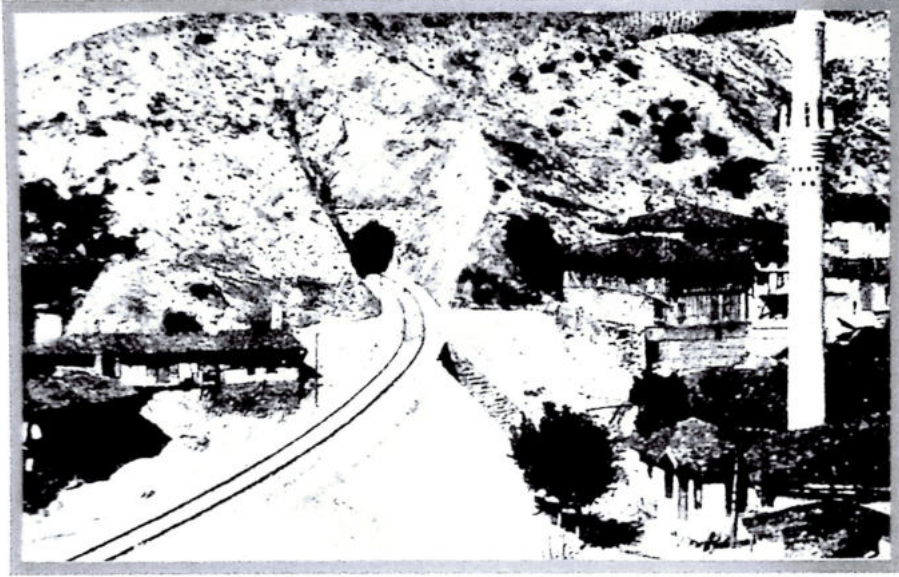
Anadolu demiryollarından bir görünüm.
